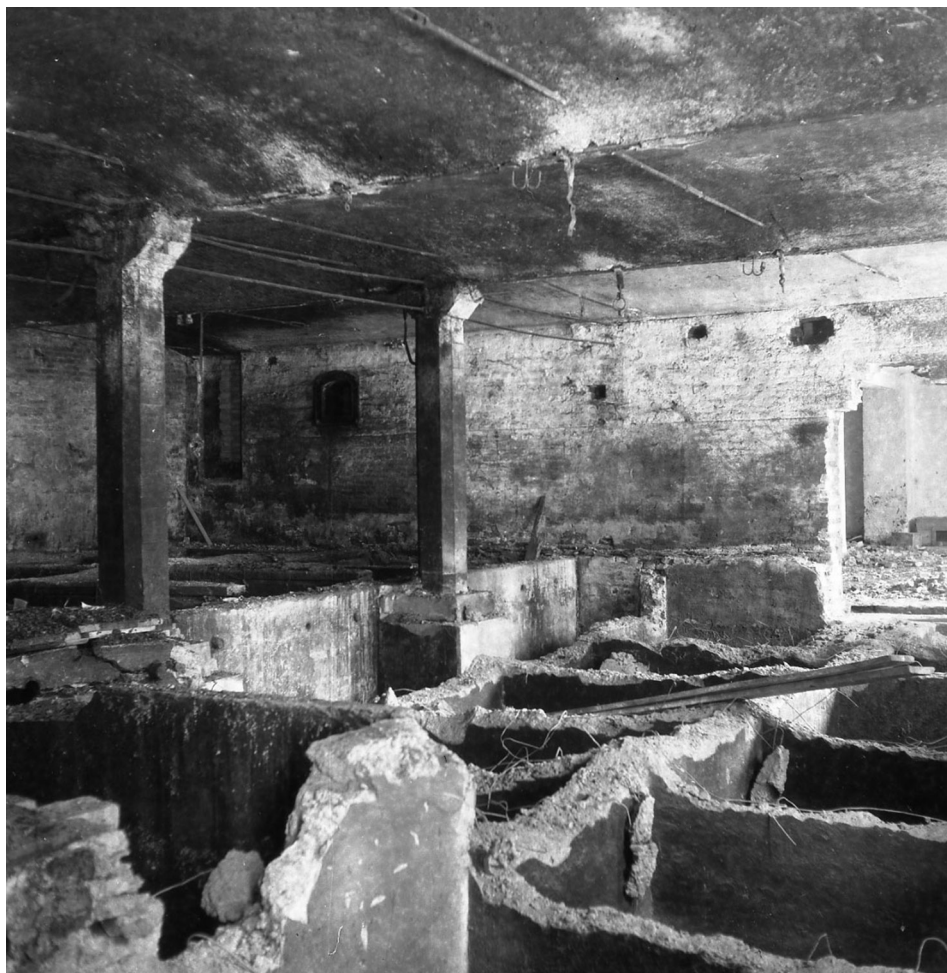
Slika 9. Adaptacija prizemlja dvorišne zgrade Gipsoteke, bazeni dubine 2,75 m, 1947., knjiga negativa, inv.br. G/B-48
