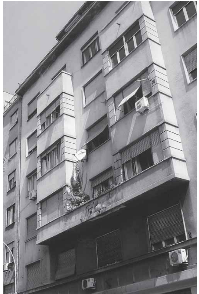
Rijeka, stambeno-poslovna peterokatnica Benko, Strossmayerova ulica 13, južno pročelje (foto: JLB)
