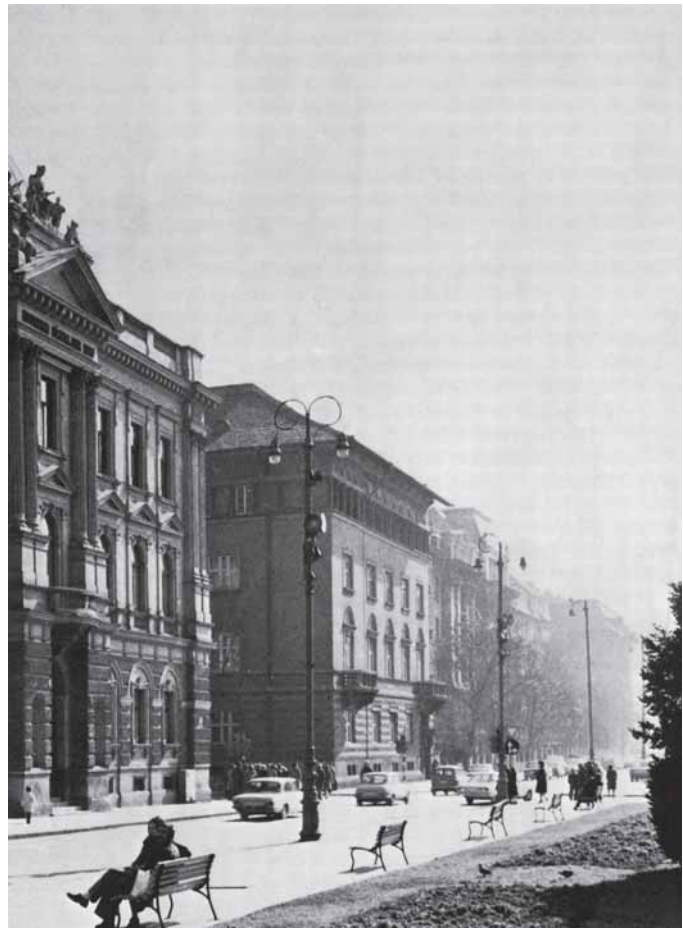
Zagreb, kuća Frank – Hebrangova/Mažuranićev trg (V. Kovačić, 1914.) Zagreb, Frank House – Hebrangova/Mažuranićev trg (V. Kovačić, 1914)
