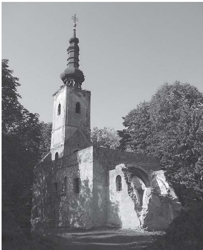
Mala Črešnjevica, Sv. Martin, pogled na svetište prije restauracije (foto: T. Tkalčec)
