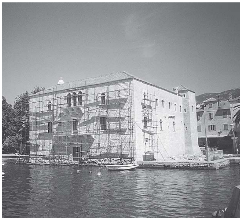
Kaštel Vitturi, pogled s jugoistoka tijekom restauracije 2001. godine (foto: D. Pivac) Castle Vitturi, southeast view during the restoration in 2001
