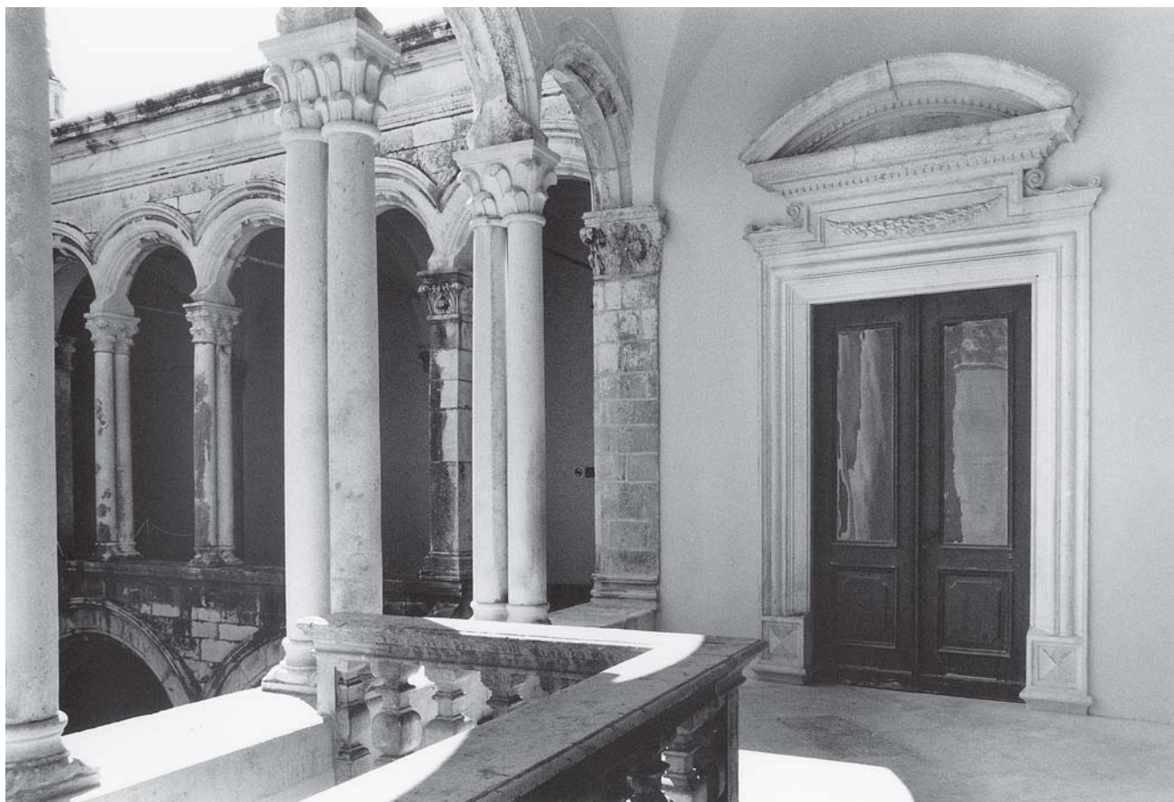
Knežev dvor, unutarnje stubište u atriju (foto: K. Horvat-Levaj) Rector's Palace, interior staircase in the atrium
