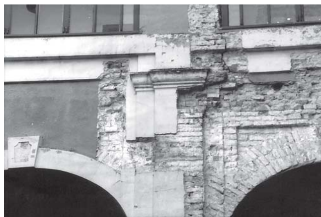
Ilok, dvorac Odescalchi, arkadno pročelje, prizemlje, nakon istraživanja
