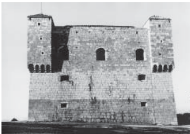
Nehaj, istočno pročelje Nehaj, east façade
