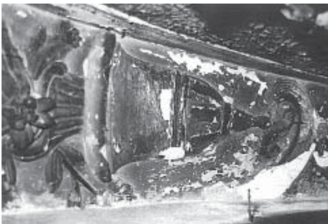
Ostaci svodne štukature otkrivene na stropu iznad Morlaiterovog oltara nakon skidanja kasetiranog stropa s Gospinim ciklusom
