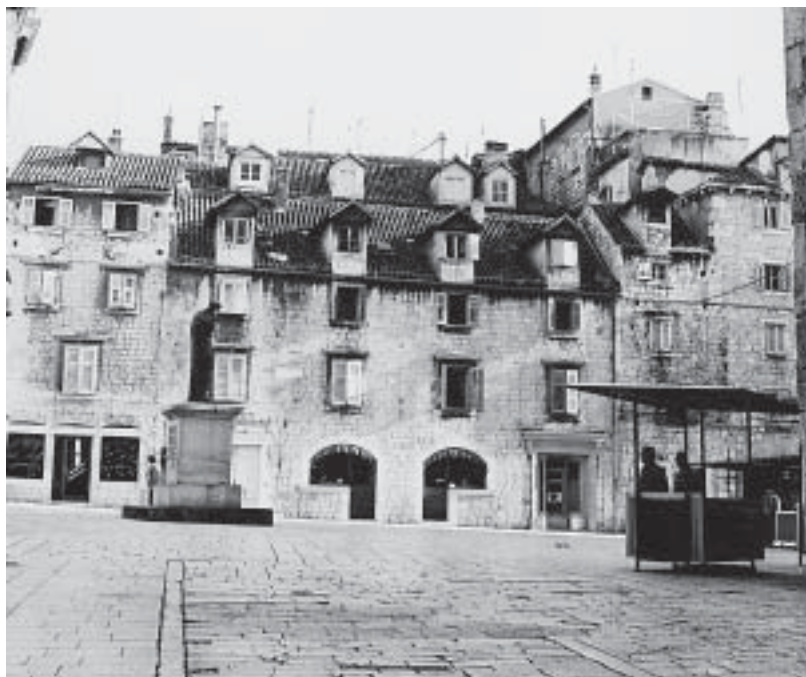
Mihovilova širina 7, pročelje (foto: P. Vranković) Mihovilova širina 7, façade
