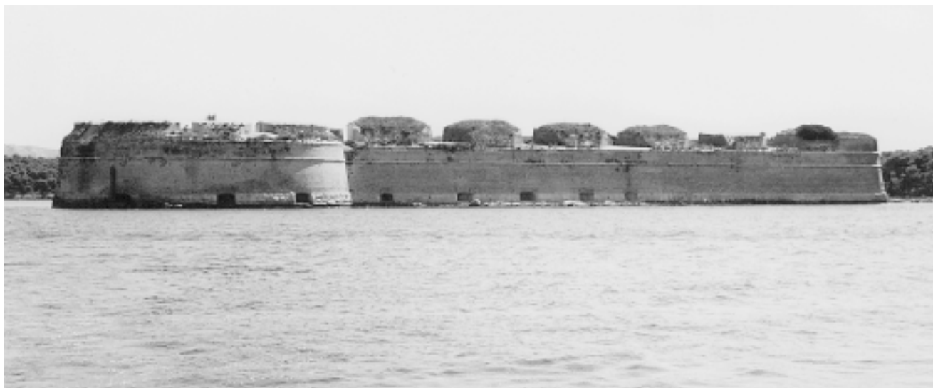
Utvrda Sv. Nikole, pogled sa zapada Fort St. Nicholas, west view
