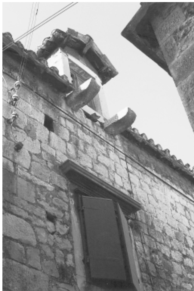
Trogir, kuća Macanović, Matice hrvatske 35, detalj luminara, južno pročelje
