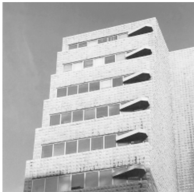
Beograd, zgrada Generalštaba, 1961; obloga prenesena u novi kontekst
