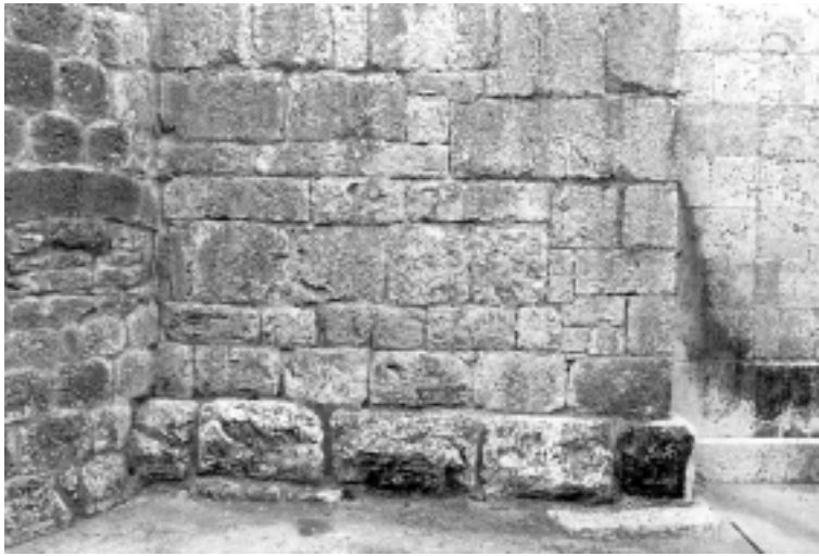
Samostan Sv. Petra Mučenika u Starom Gradu, podnožje sjevernog pročelja zvonika s vidljivim megalitima temelja
