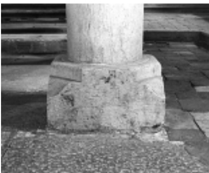
Žbandaj, crkva Sv. Ivana i Pavla, unutraš- njost, baza stupa Žbandaj, Church of SS John and Paul, interi- or, column base
