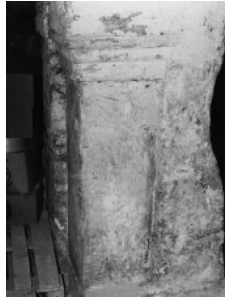
Stupac ugrađen u središnji nosač podrumske prostorije bočnoga krila. I danas je vidljiv ostatak jednostavno profiliranog kapitela, kakve nalazimo i na dva stupca u sjevernom dijelu prostorije; snimio A. Žmegač
