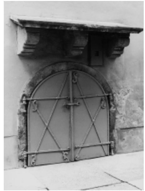
Okvir i vrata podrumskog ulaza na južnom pročelju uličnog krila. Natkriven je kamenom nadstrešnicom koju pridržavaju tri konzole; snimio A. Žmegač Door and frame of basement entrance, with porch supported by three consoles on the south facade of the wing facing the street (photo: A. Žmegač)
