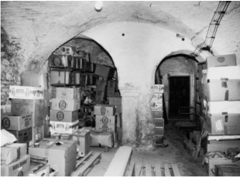
Podrumska prostorija bočnog (dvorišnog) krila raščlanjena je lučno zaključenim nosačima u koje su ugrađeni stupci; snimio A. Žmegač The basement room of the lateral wing is articulated by arched supports with built-in columns (photo: A. Žmegač)
