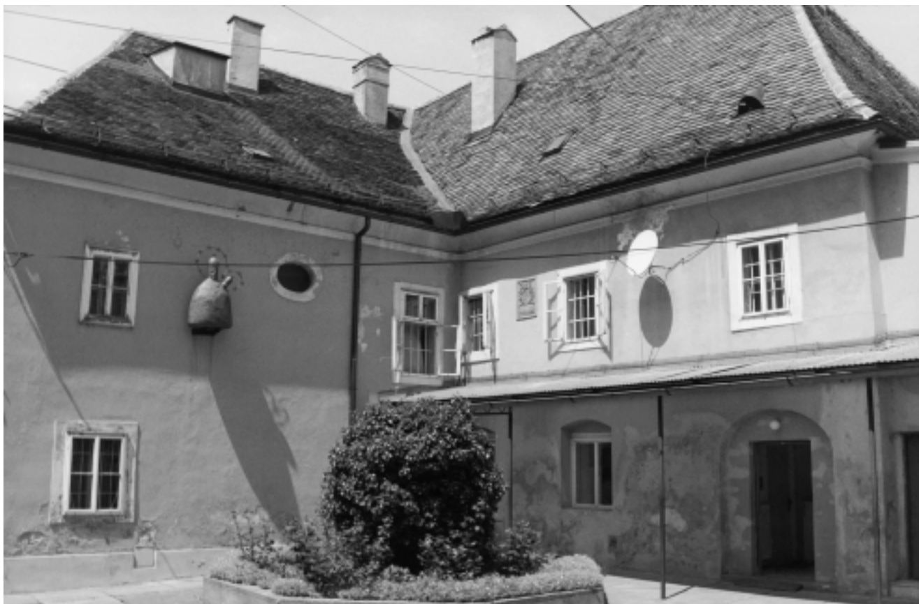
Dvorišna pročelja kurije. Na zoni kata vidi se kamena ploča s grbom Ivana Znike i godinom izgradnje kurije; snimio T. Križić Facades facing the yard. On the first floor a stone slab with Ivan Znika's coat of arms and year of construction (photo: T. Križić)
