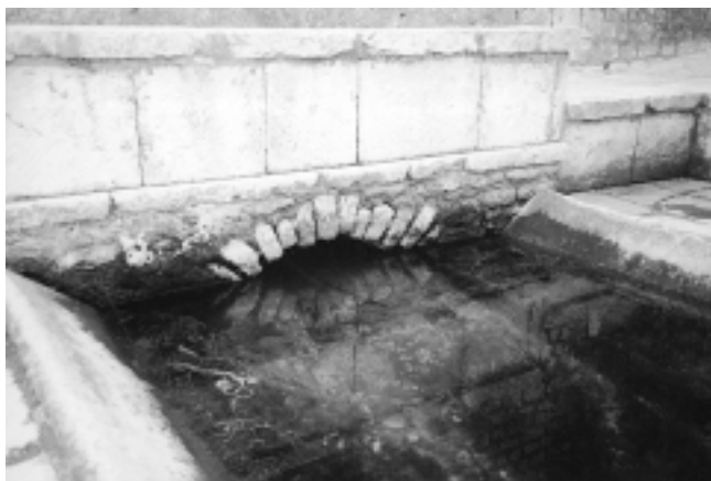
Ušće kanala kojim istječe voda iz ribnjaka Hektorovićeve ljetnikovca
