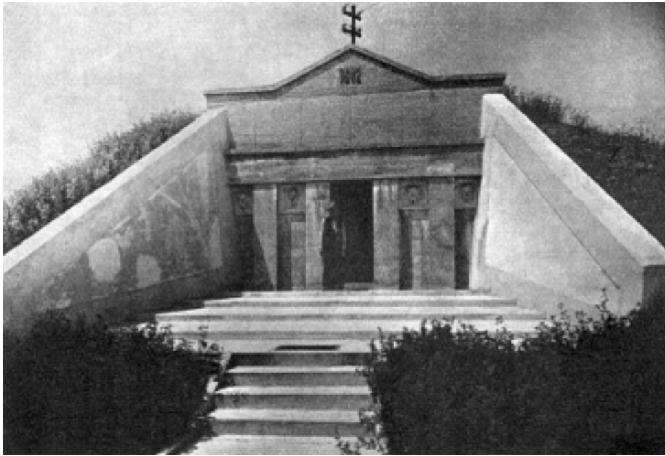
Viktor Kovačić (konstruktor inž. Alois Thim), portal zasunske komore Gradskog vodovoda na Tuškancu (Jabukovac) u Zagrebu, (1912)
