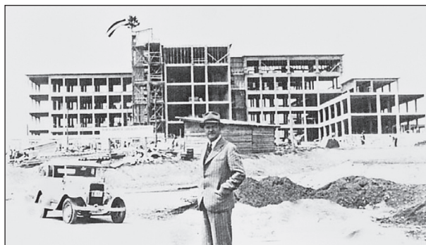
Sl. 1. Izgradnja bolnice na zagrebačkom Rebru prije II. svjetskog rata.
