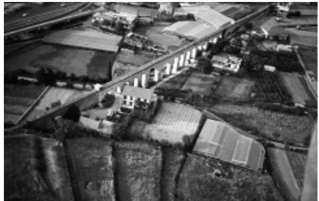
17. Antički akvedukt Split–Solun primjer je ljepote rimskog graditeljstva – kuća u neposrednoj blizini primjer je suvremenog barbarizma
