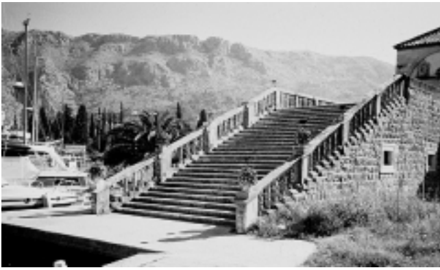
8. Sorkočevićev ljetnikovac u Rijeci dubrovačkoj s monumentalnim manierističkim stubištem što je povezivalo terasu s morem, a sada se utapa u armiranobetonskoj obali
