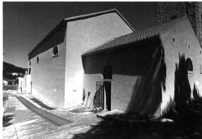
Crkva sv. Lovre u Kalima; izgled južnog lica i sakristije, nastao do 1777. g. (foto: M. Stagličić) Church of St. Lawrence in Kali; south front and sacristy, built before 1777 (photo: M. Stagličić)
