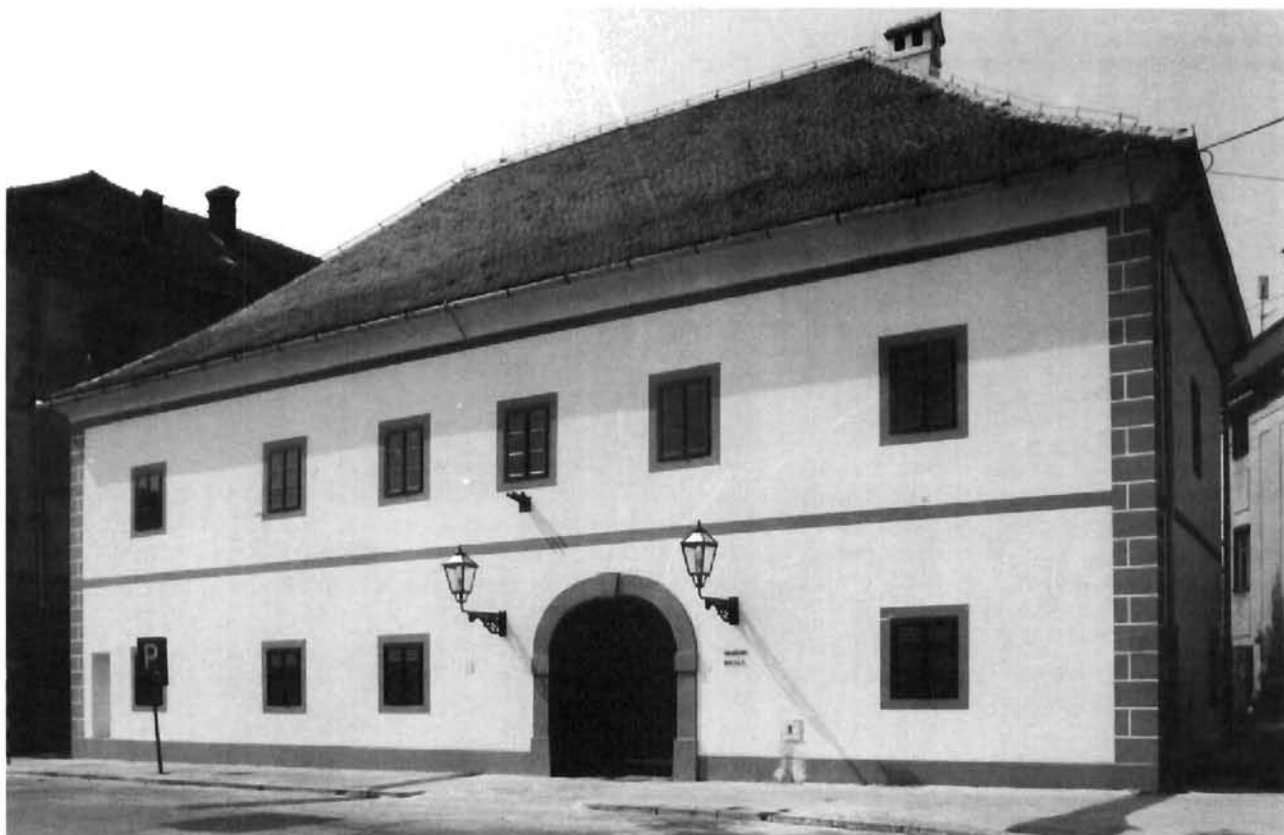
Karlovac, Gradski muzej, pročelje zgrade obnovljeno neposredno prije ratne agresije (iz dokumentacije Zavoda za zaštitu spomenika kulture Karlovac)
