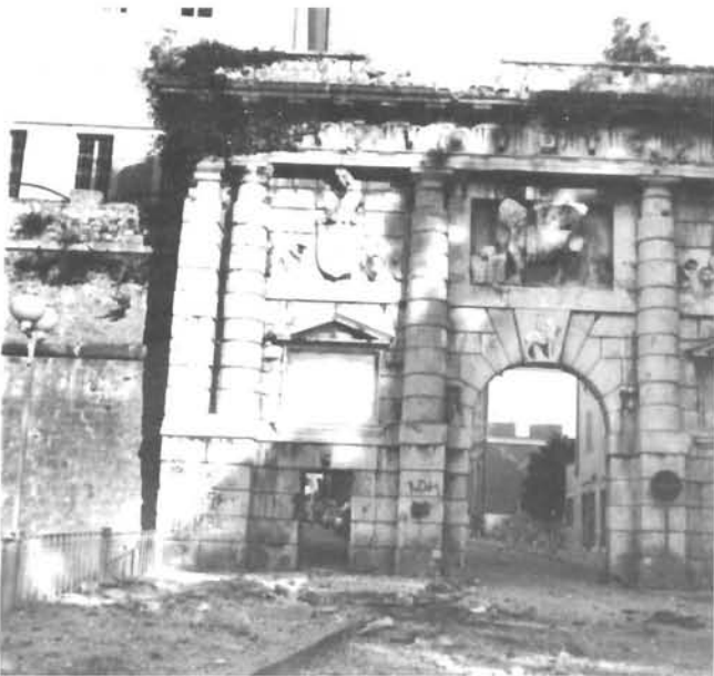
Zadar, kopnena gradska vrata, 1543. godina, oštećenje gornjeg vijenca (foto: P. Vežić)
