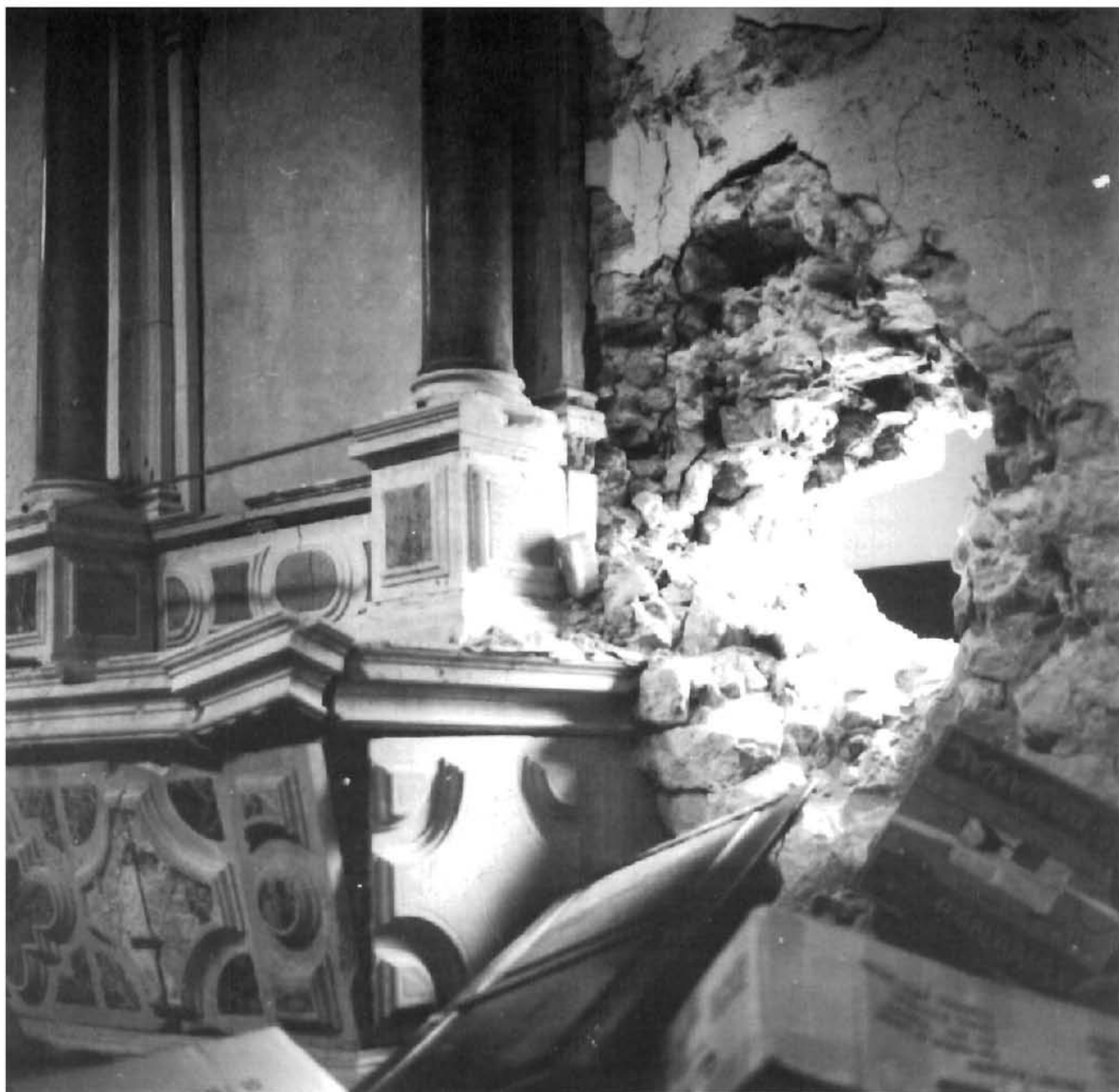
Zadar, Crkva sv. Krševana, oštećenje na sjevernom zidu i oltaru (foto: P. Vežić) Zadar, St. Chrysostom Church, damage on the north wall and altar (photo: P. Vežić)
