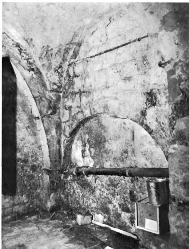
Zazidani luk svoda prijašnje ulice ( sub varicos ), prizemlje kuće u Ulici kneza Damjana Jude 4
