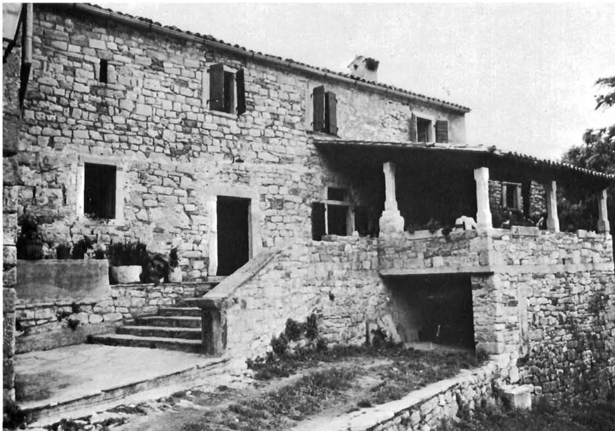
Hum, stambena kuća u južnom nizu, pročelje kojeg čini gradski zid
