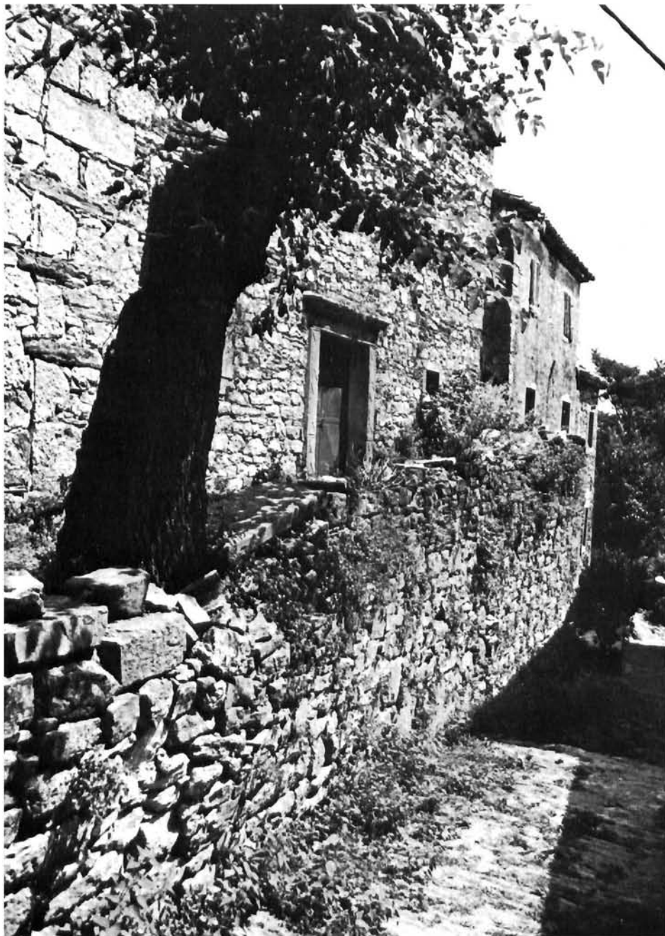
Hum, stambena kuća u sjevernom nizu, pročelje s portalom datiranim 1732. godinom
