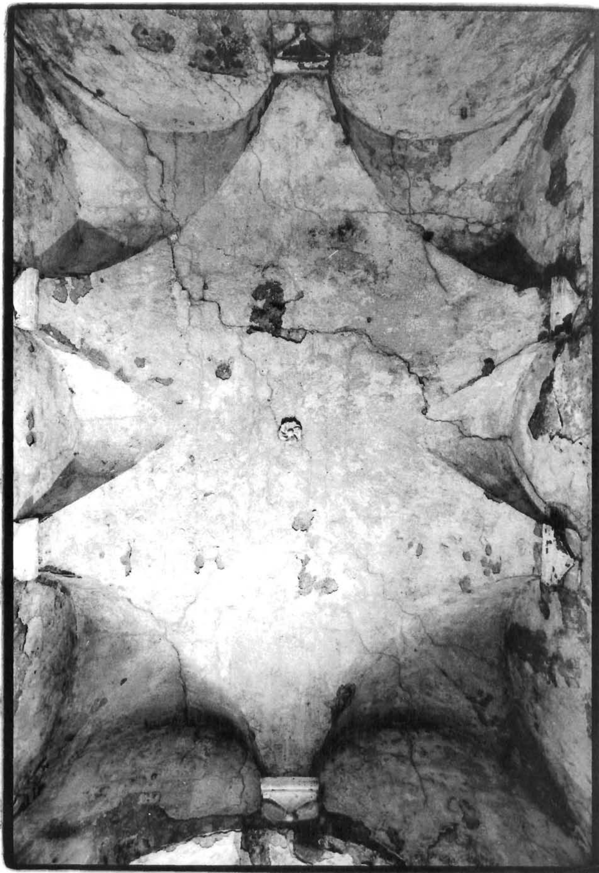
Svod u bočnoj prostoriji The ceiling in a side room
