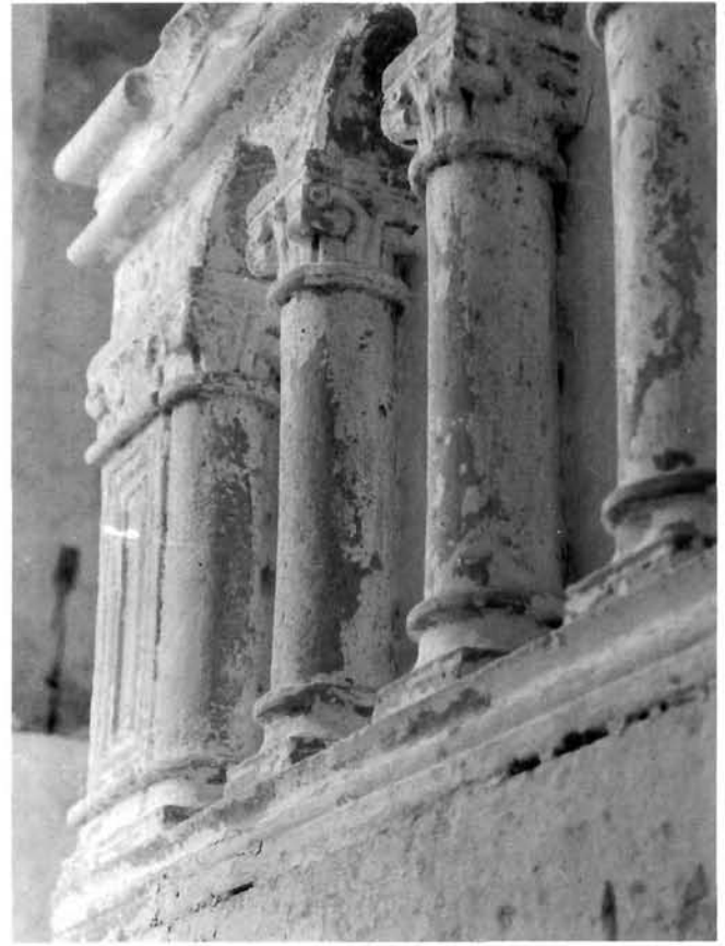
Ograda stubišta (snimka 1963) The staircase railing
