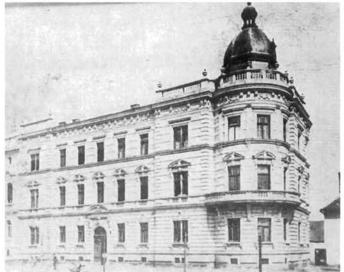
Zagreb, kuća M. Halpera, pročelje, Strossmayerov trg 3 (Hönigsberg i Deutsch, 1886/7) Zagreb, M. Halper's house, facade, 3 Strossmayer Square (Hönigsberg and Deutsch, 1886/7)
