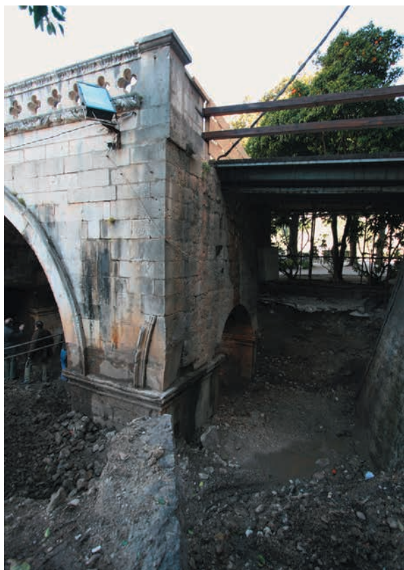
sl. 26. Tragovi trećeg luka Paskojeva mosta (foto: Ž. Peković).
