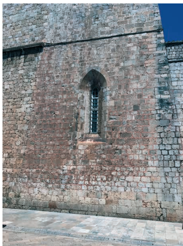
sl. 7. Prizemlje zvonika male braće s uočljivom fugom između crkve i zvonika (foto: Ž. Peković).
