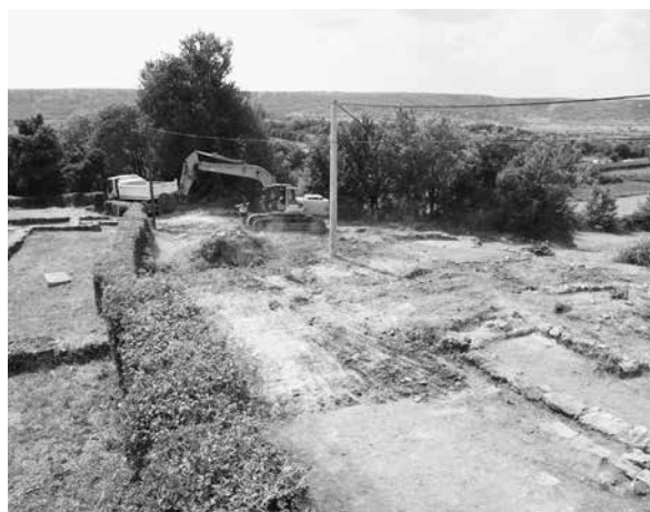
sl. 11. Uklanjanje asfalta sa seoske prometnice i odvoz otpada s Male Crkvine 2011. godine (foto: A. Jurčević).
