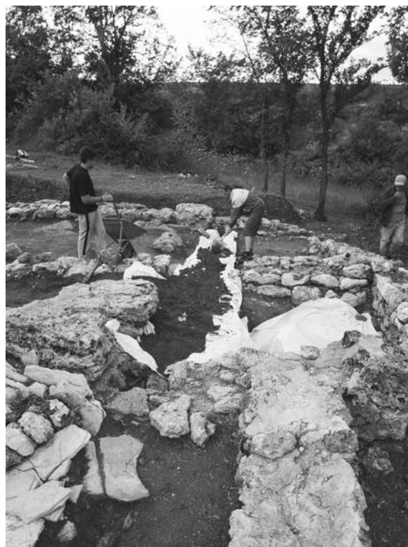
sl. 64. Oblaganje kanala za otjecanje geotekstilom (foto: A. Jurčević).
