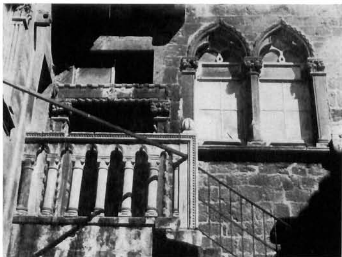
18. Stubišna ograda Papalićeve palače prije uklanjanja 1950.
