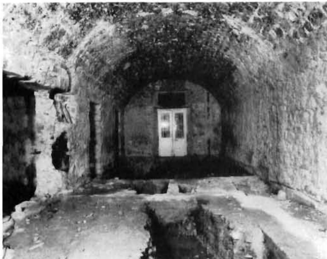
11. Južni svodeni prostor (foto: Miljenko Mojaš) 11. The south vaulted area (photo: Miljenko Mojaš)
