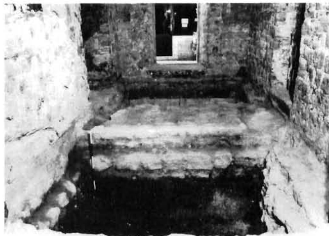
4. Fortifikacijski zid (foto: Miljenko Mojaš) 4. Fortification wall (photo: Miljenko Mojaš)
