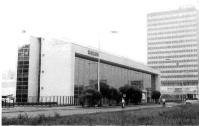
Duško Rakić – poslovna zgrada Vjesnika, Slavonska avenija 4 (1987) – sjeverno pročelje
