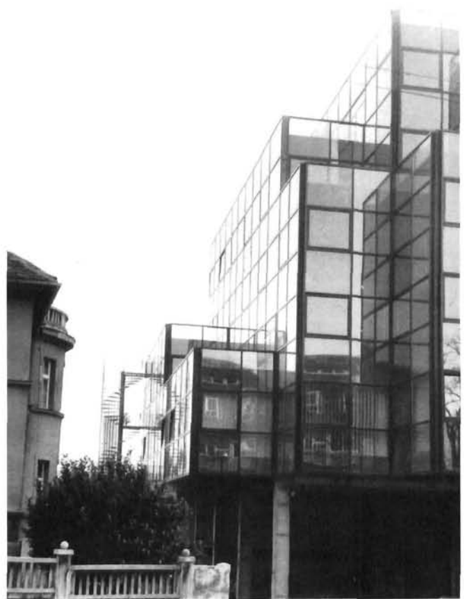
Grujo Golijanin – poslovna zgrada, Vončinina 2 (1968-1983) – detalj pročelja Grujo Golijanin – business building – Vončinina 2 (1968-1983) – a detail of the facade
