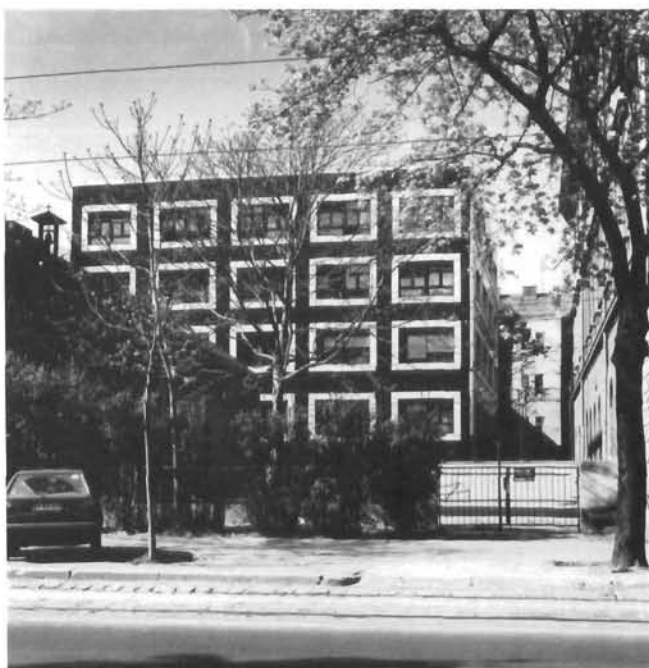
Milan Šosterić – poslovna zgrada Gradskog telefona, Branimirova/Palmotičeva (1984-1987) – pročelje Milan Šosterić – the City telephone building, Branimirova/Palmotičeva (1984-1987) – the facade
