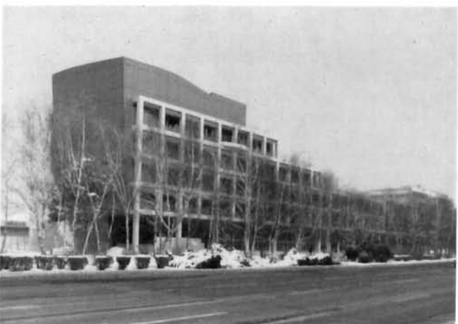
Đivo Dražić, Edvin Šmit – poslovna zgrada carina i Intereurope na Zagrebačkom velesajmu (1990-1991) – južno pročelje Đivo Dražić, Edvin Šmit – the customs and Intereuropa building at the Zagreb Fair (1990-1991) – the south facade
