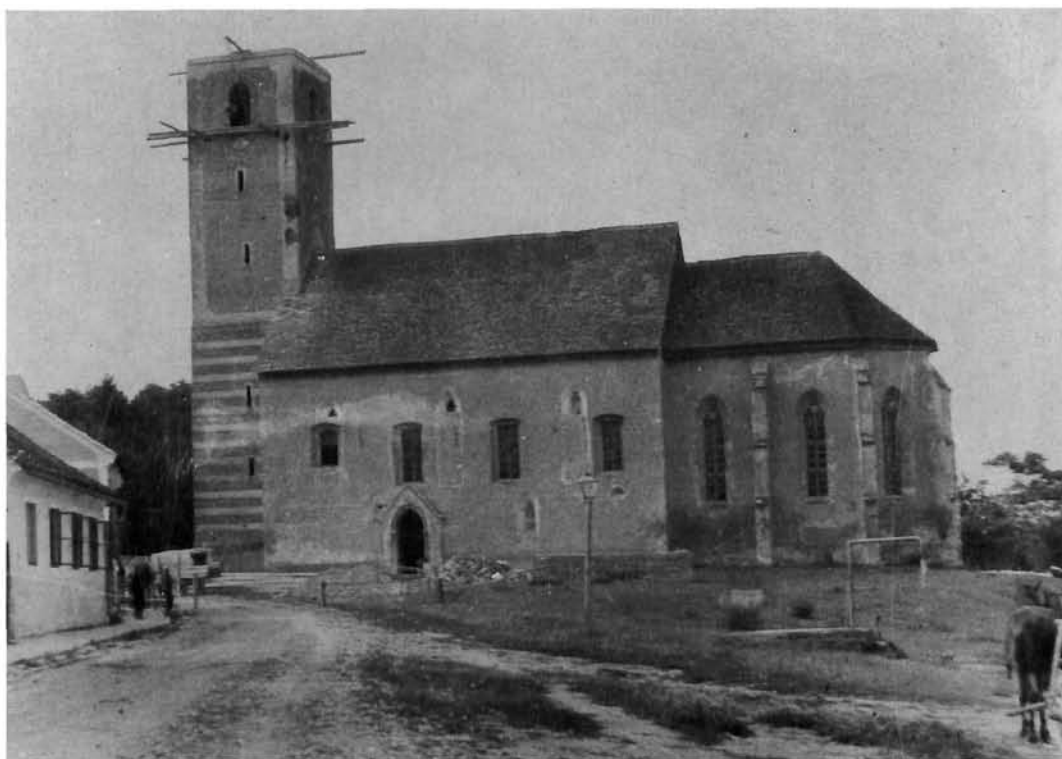
Crkva sv. Križa za vrijeme obnove 1912. godine, južna strana s otkrivenim ranogotičkim i gotičkim monoforama broda (foto: Gjuro Szabo) The church of the Holy Cross during reconstruction in 1912. the south side showing the early Gothic and Gothic monofores of the nave (Photo Gju-ro Szabo)
