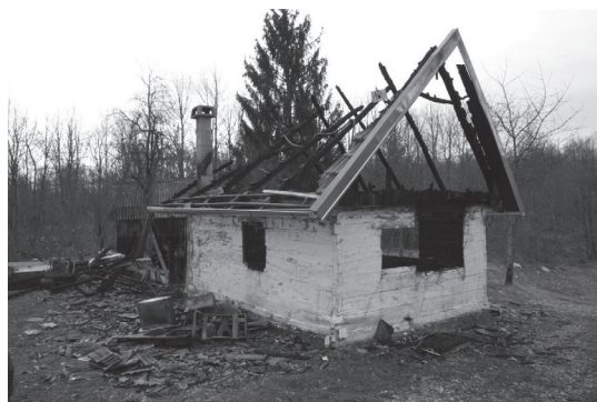
Slika 1. Požar drvene kuće
