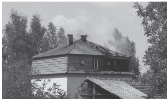
Slika 2. Požar obiteljske kuće „Vila Mila“
