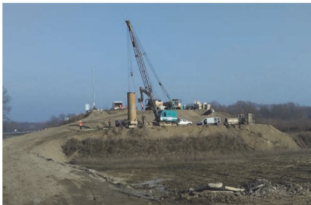
Slika 4. Garnitura za bušenje pilota na upornjaku U1, obala RH
