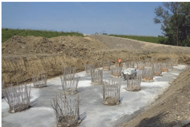
Slika 5. Uređene glave pilota i izveden podložni beton naglavne grede temelja stupišta S6, obala BiH
