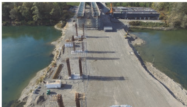
Slika 8. Dovršena čelična konstrukcija do stupišta S5, plato s makroelementima i privremeni oslonci između stupišta S5 i S4, obala BiH
