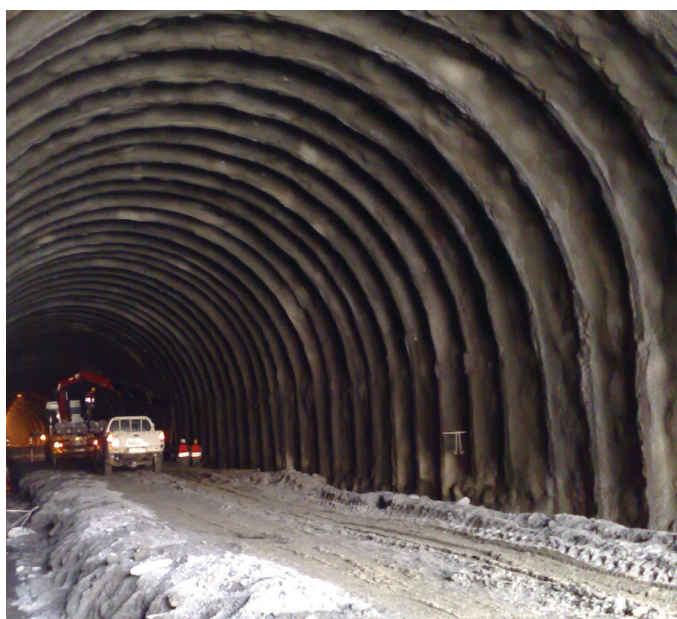
Primarna podgrada tunela sa čeličnim lukovima
