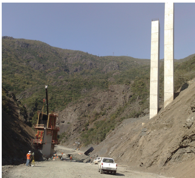
Namještanje oplate kampade stupa vijadukta
