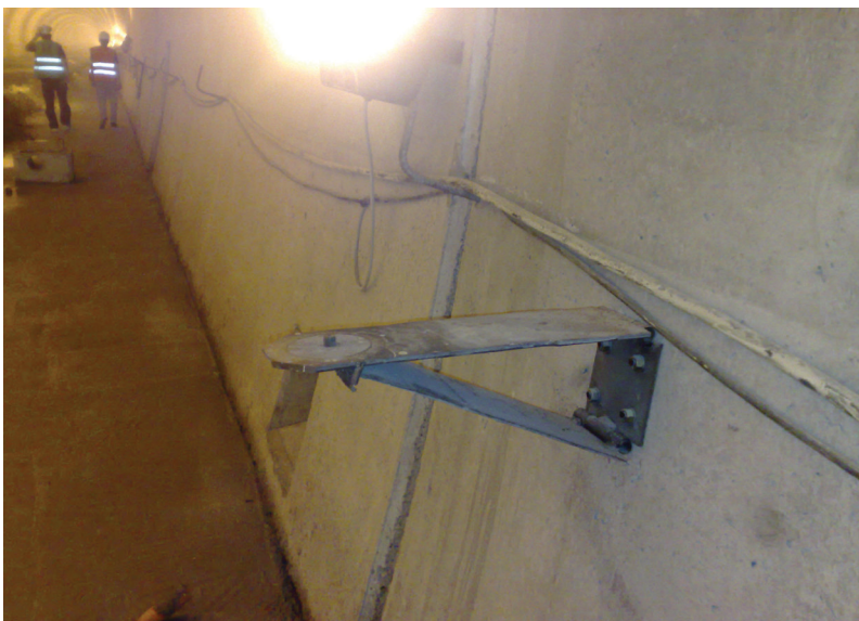
Stabilizacija točke u tunelu
