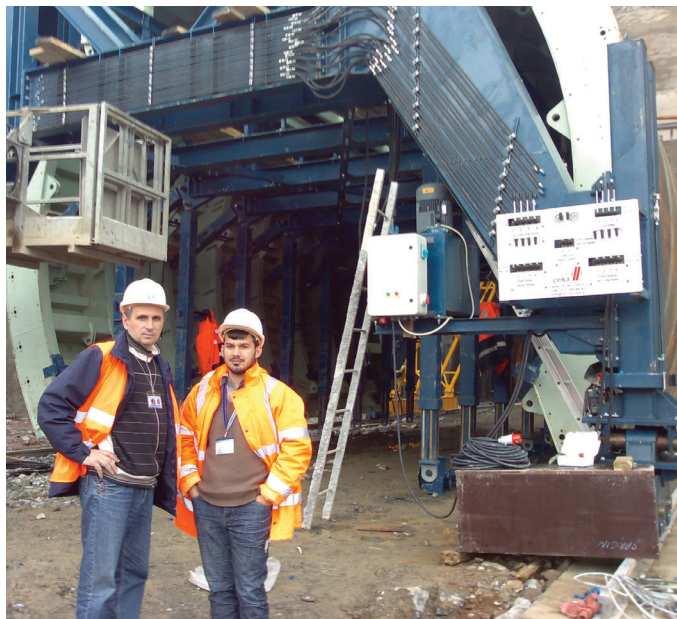
Ispred tunelske oplate za betoniranje tunela
