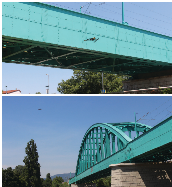
Slika 3.6. Bespilotna letjelica Falcon 8 Trinity tijekom snimanja željezničkog mosta
