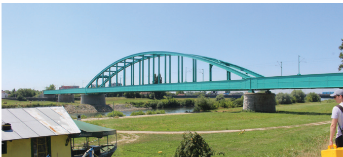
Slika 3.1: Željeznički most preko rijeke Save u Zagrebu
