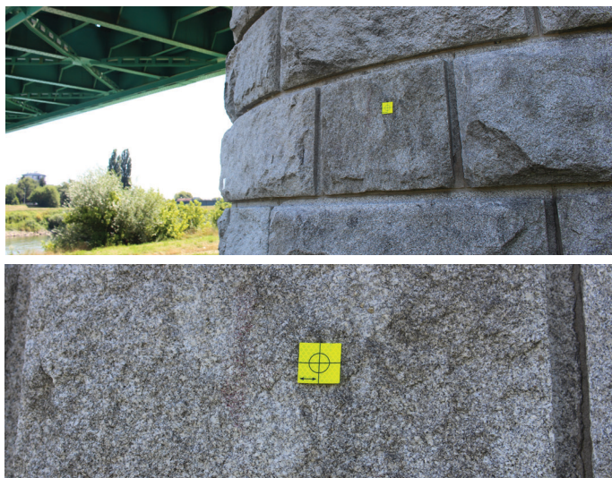
Slika 3.4. Novopostavljene mjerne markice na istočnoj strani mosta – stup B; a) položaj mjerne markice, b) uvećani prikaz
