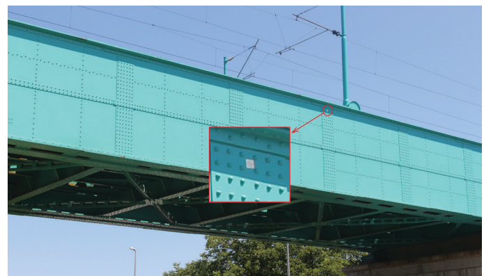
Slika 3.3. Otprije postavljene mjerne markice na zapadnoj strani željezničkog mosta
