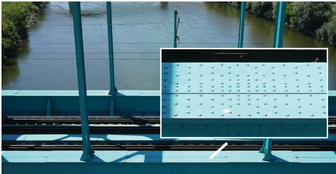
Slika 4: Prikaz mogućnosti primjene fotografija visoke rezolucije za potrebe inspekcije
