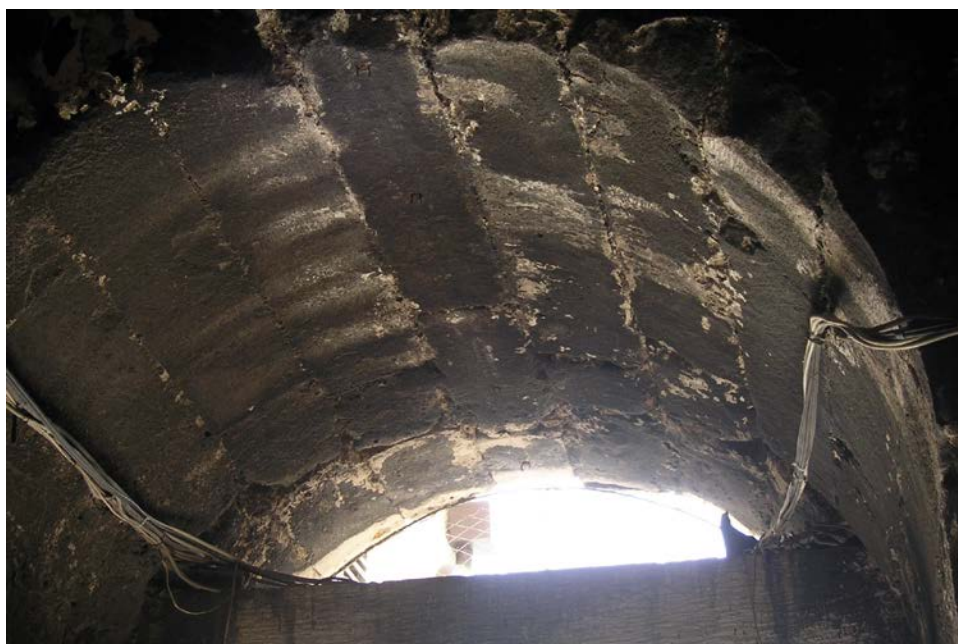
Slika 6 Željezne alkice u svodu južnih vrata Dioklecijanove palače (snimio D. Maršić)
