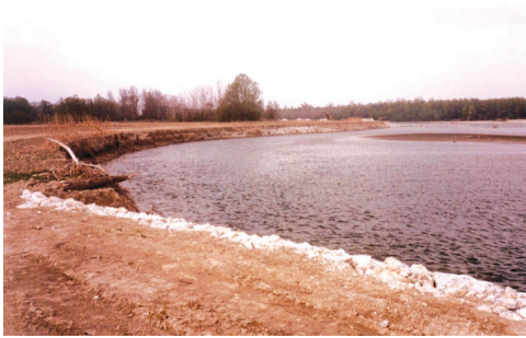
Fotografija br. 4: Pogled na SZ, na trag meandrirajuće – lateralne (bočne) erozije rijeke Drave kod Ferdinandovca. Konkav je oblikovan u posljednje dvije godine. Drava je erodirala desnu obalu za više od 150 metara. Upravo stoga se vrše regulacijski radovi na sprečavanju ekscesivne erozijske aktivnosti vodotoka, izgradnjom posmjernih objekata, (ožujak 2003. godine).
