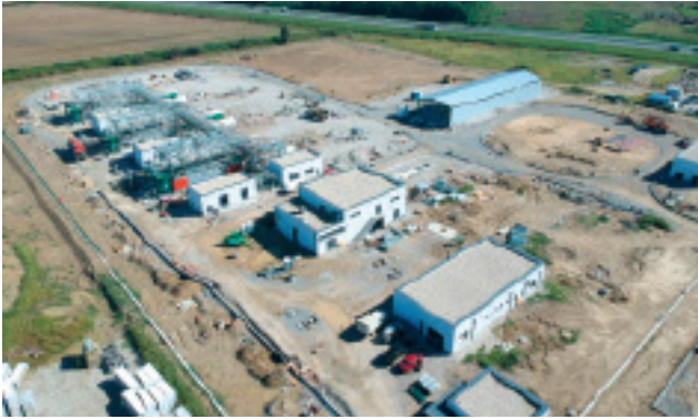
Slika 11. Gradilište kompresorske stanice (kolovoz 2019.)
