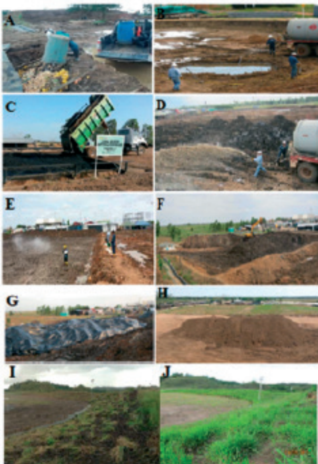
Slika 3. Postupak obrade naftnog mulja po fazama na polju Caracara u Kolumbiji (Molano, 2018)
