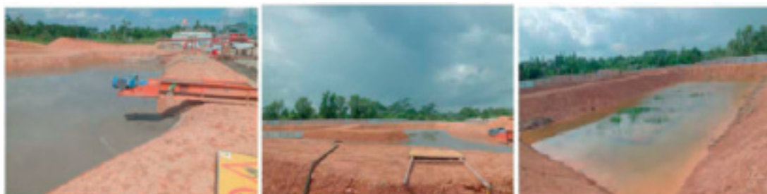
Slika 8: Prikaz jame s tekućom fazom isplake od početne (lijevo) do završne faze (desno) „online“ bioremedijacije (Lesto & Kasumo, 2015)
