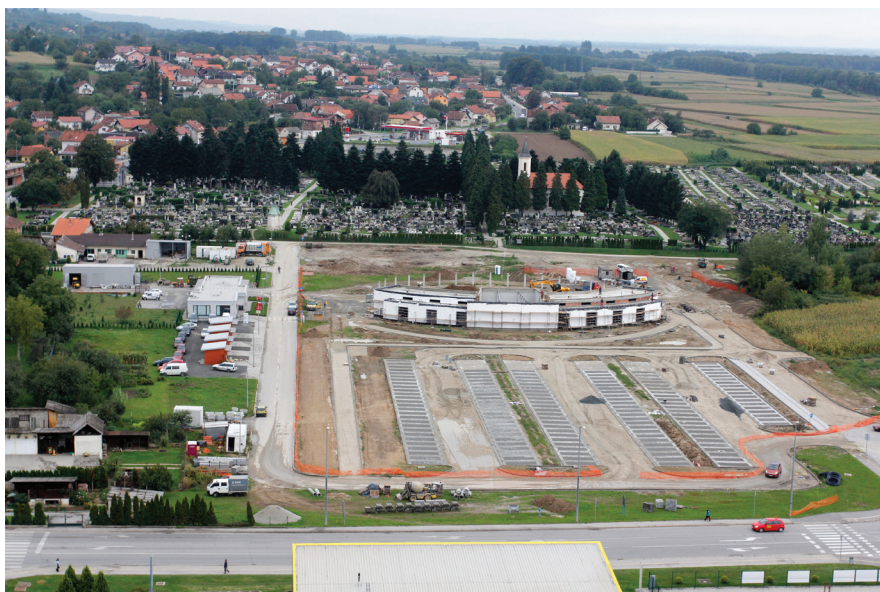
Gradnja nove mrtvačnice na koprivničkom groblju.
