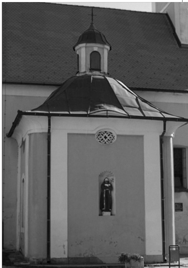
Sl.2. Koprivnica, crkva sv. Antuna Padovanskoga, kapela Presvetoga Otkupitelja, sjeverno pročelje (foto: N. Kušenić).
