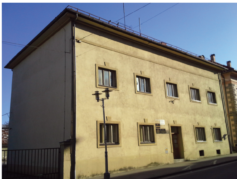
Sl. 14. Stan zapovjednika, kasnije zgrada zapovjedništva obrane u NDH – danas Šumarinja Gospić u Kaniškoj 15 – glavno ulično pročelje, 1957. (foto: V. Šulentić, 22. 5. 2016.)
