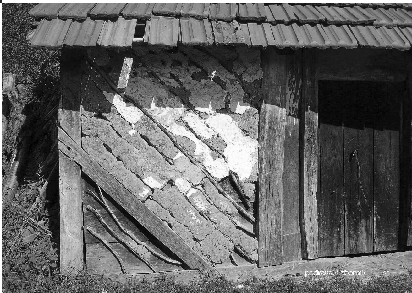
Sl.2. Raster kalanih prutova na drvenim stijenama činio je podlogu za sloj žbuke sastavljene od ilovače i pljeve (foto: M. Zebec, 2008.).
