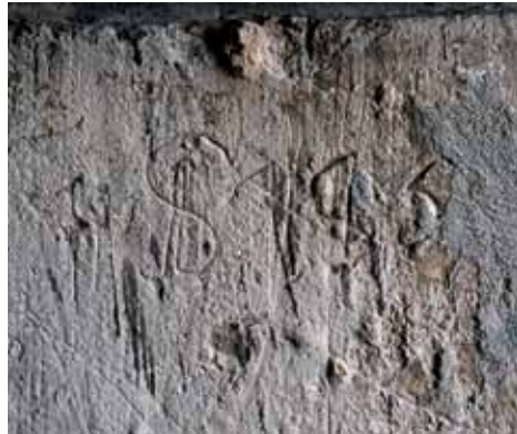
Nevješto urezana godina 1785. na glavnom portalu, vjerojatno datira neku od obnova. (Hrvatski restauratorski zavod)
