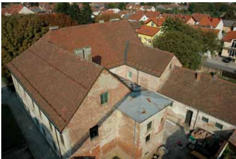
Pogled na zgradu iz zraka s jugozapada, 2009. (Hrvatski restauratorski zavod)
