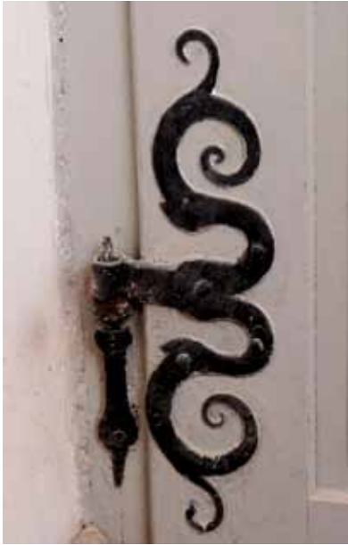
Bravarija 18. stoljeća na vratima između veže i jugozapadne prostorije. (Hrvatski restauratorski zavod)
