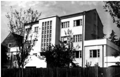
Prvobitni izgled zgrade Internog odjela 1936.g.
