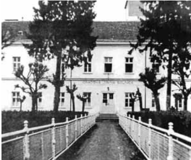
Pročelje s ulazom u bolnicu i ogradom oko parka
