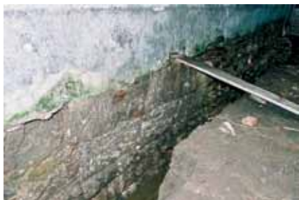
Klesanci u Križovljanu, temelj crkve sv. Križa, sjeverni zid
