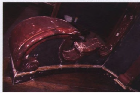
Detalj volute nakon sanacije oštećenja drvenog nosioca i krediranja.
