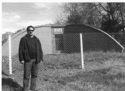
Rezervar vode iz vodovoda punjenog prirodnim padom u Hampovici
