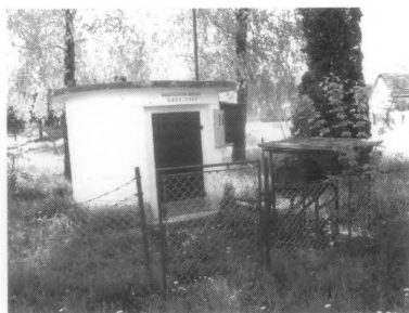
Vodovodna pumpa u Čepelovcu
